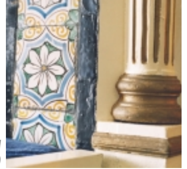
Détail de revêtement mural en céramique (19e siècle)
