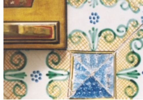
Détail de revêtement mural en céramique (19e siècle)
