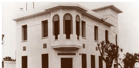
Immeuble de l'agence Banque de Tunisie à Kairouan construit en 1931.
