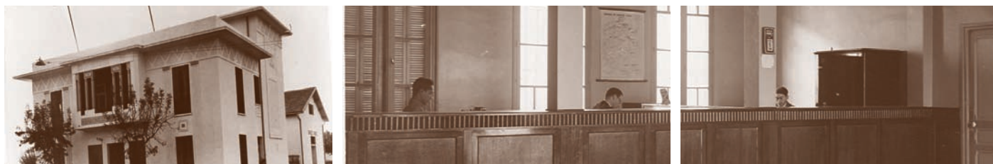
Immeuble de l'agence Banque de Tunisie ^ Boussalem ex Souk KHEMIS, construit en 1929.
